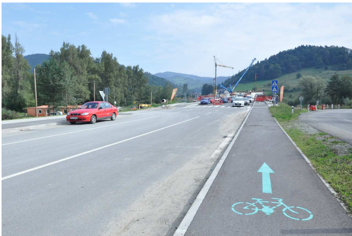
Foto 52 – Mníšek nad Popradom – pohľad na stavbu cestného mosta cez rieku Poprad, vpravo odbočka cesty 3. triedy smer Kače - Medzibrodie
