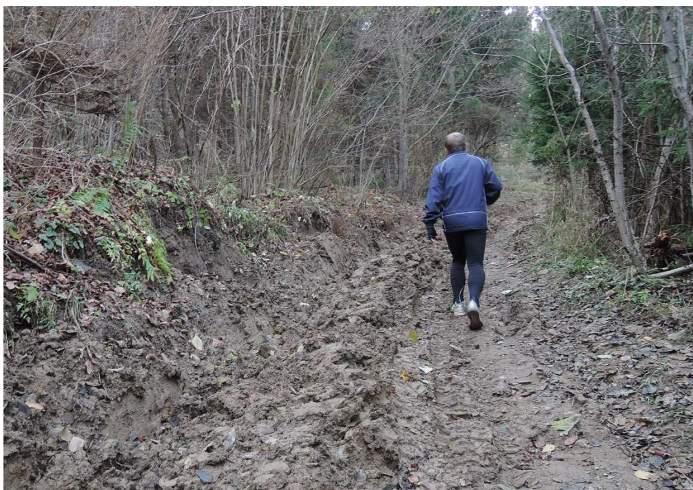
Foto č. 7. Na obecnej ceste prebiehajú zemné práce a úpravy terénu, strmý úsek
