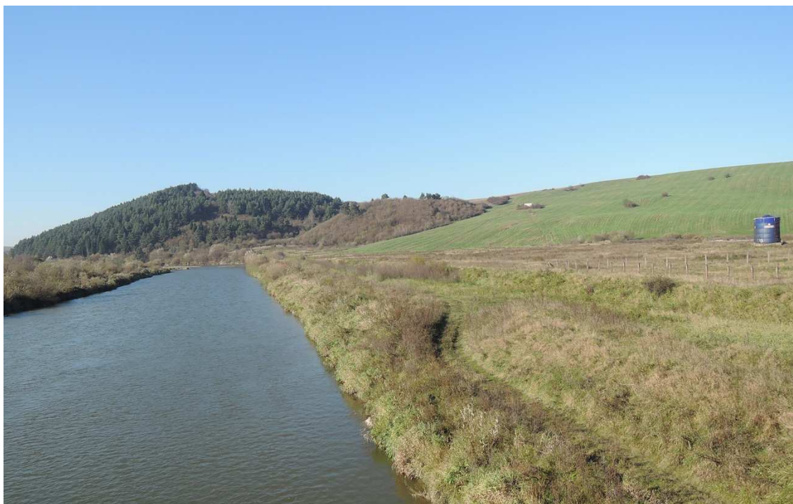
Foto 32. Plaveč - pohľad zo železničného mosta na úsek trasy smer lávka cez Poprad do obce Plavnica. Trasa vedie popod zalesnený kopec Sosnový vrch v pozadí v tesnej blízkosti rieky.
