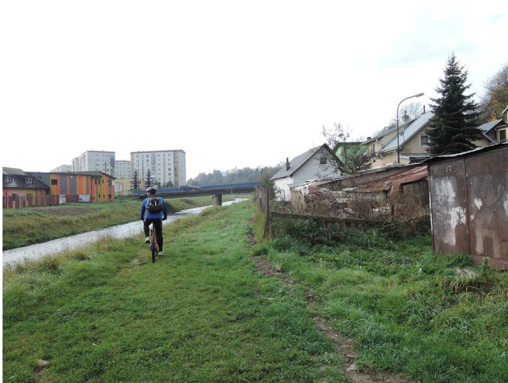
Foto č. 12. Ľavý breh potoka Jakubianka, nutný podjazd popod cestný most v pozadí (Prešovská ul.)
